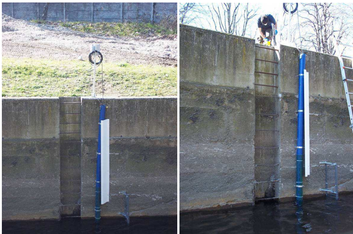
Figura 27 – Installazione della sonda S/N 13M101704 all'interno del CSNO
